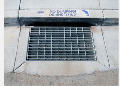
Sólo la lluvia debe ingresar al sistema de desagüe pluvial.
