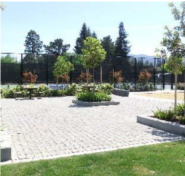
Pervious pavers at Rosita Park, Los Altos
